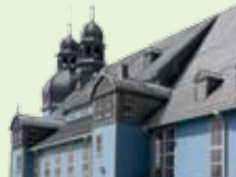
Baustelle Marktkirche Clausthal
